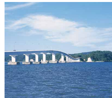
能登島と七尾市石崎町を結ぶ「能登島大橋」
