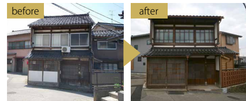
↑ 金澤町家再生生活事業で改修された“金澤町家”
